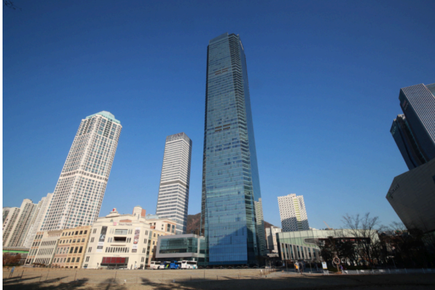
부산문현금융단지 내 부산국제금융센터(BIFC) 전경. 부산일보DB
